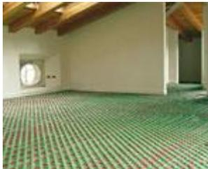
Prima della posa dello strato di supporto, per verificare che durante le operazioni di posa non siano stati accidentalmente causati danni alle tubazioni, si deve procedere al riempimento dei circuiti, anello per anello, ed allo sfogo delle eventuali sacche d'aria presenti. Successivamente si esegue una prova con acqua ad almeno due volte la pressione di esercizio prevista e comunque non inferiore a 6 bar.
