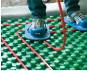
La posa del tubo avviene seguendo le indicazioni progettuali, cercando di seguire i percorsi consigliati per garantire le rese desiderate. Nella posa delle tubazioni è necessario effettuare curvature con raggio minimo conforme a quanto previsto dalle caratteristiche del tubo.
