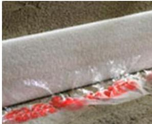
La fascia perimetrale va posata lungo le pareti e lungo qualsiasi altro componente che penetra nel sottofondo (ad esempio colonne): si tratta di una striscia isolante che ha lo scopo di collegare la base di supporto con la superficie del pavimento finito in modo da consentire un movimento del sottofondo di alcuni millimetri.
