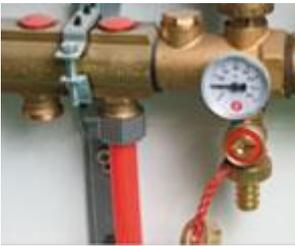
Il caricamento dell'impianto deve essere effettuato in maniera accorta in modo da rimuovere l'aria contenuta nelle tubazioni. Questo procedimento va eseguito manualmente riempiendo i tubi con la seguente procedura:
