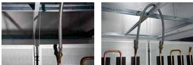
图2.15 C75辐射板与预装配连接组件的连接
