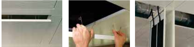
辐射板由安全弹簧固定，一旦打开，就可以竖直放置。
