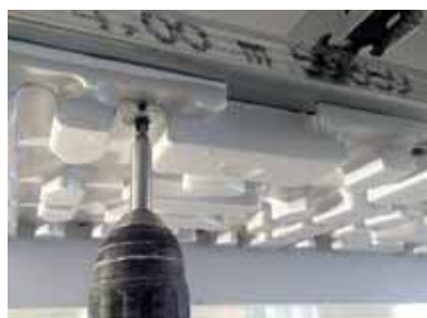
使用35毫米螺丝将边缘辐射板安装在金属龙骨上
