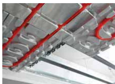
沿预成型边缘辐射板安装R883-1辐射板和管道
