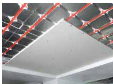
按照现行标准进行压力试验后，在支撑龙骨上安装石膏板
