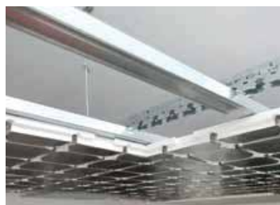
安装300 mm间距的金属结构龙骨
