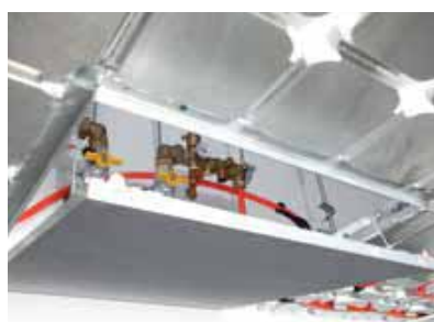
在安装分集水器的区域安装检查口
